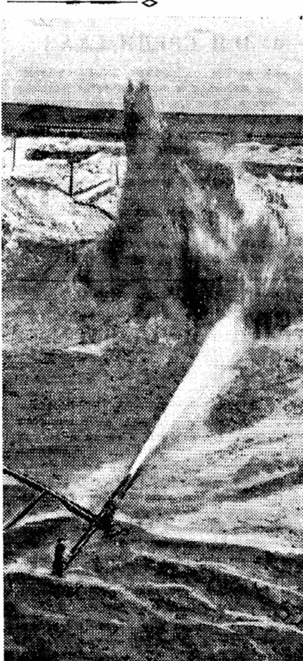
Назаровский угольный разрез. Работает гидромонитор...
